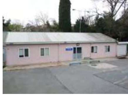
Asya Yakası Yapı ve Malzeme Laboratuvarı
